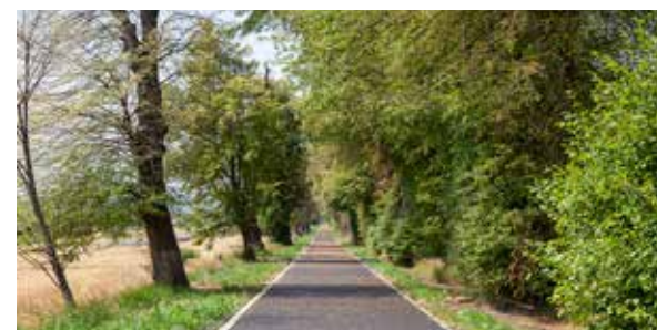
Ścieżka wzdłuż alei lipowej jest już niemal gotowa. Już w przyszłym roku rowerzyści będą tu mieli ponad 20 kilometrów świetnie przygotowanych dróg
