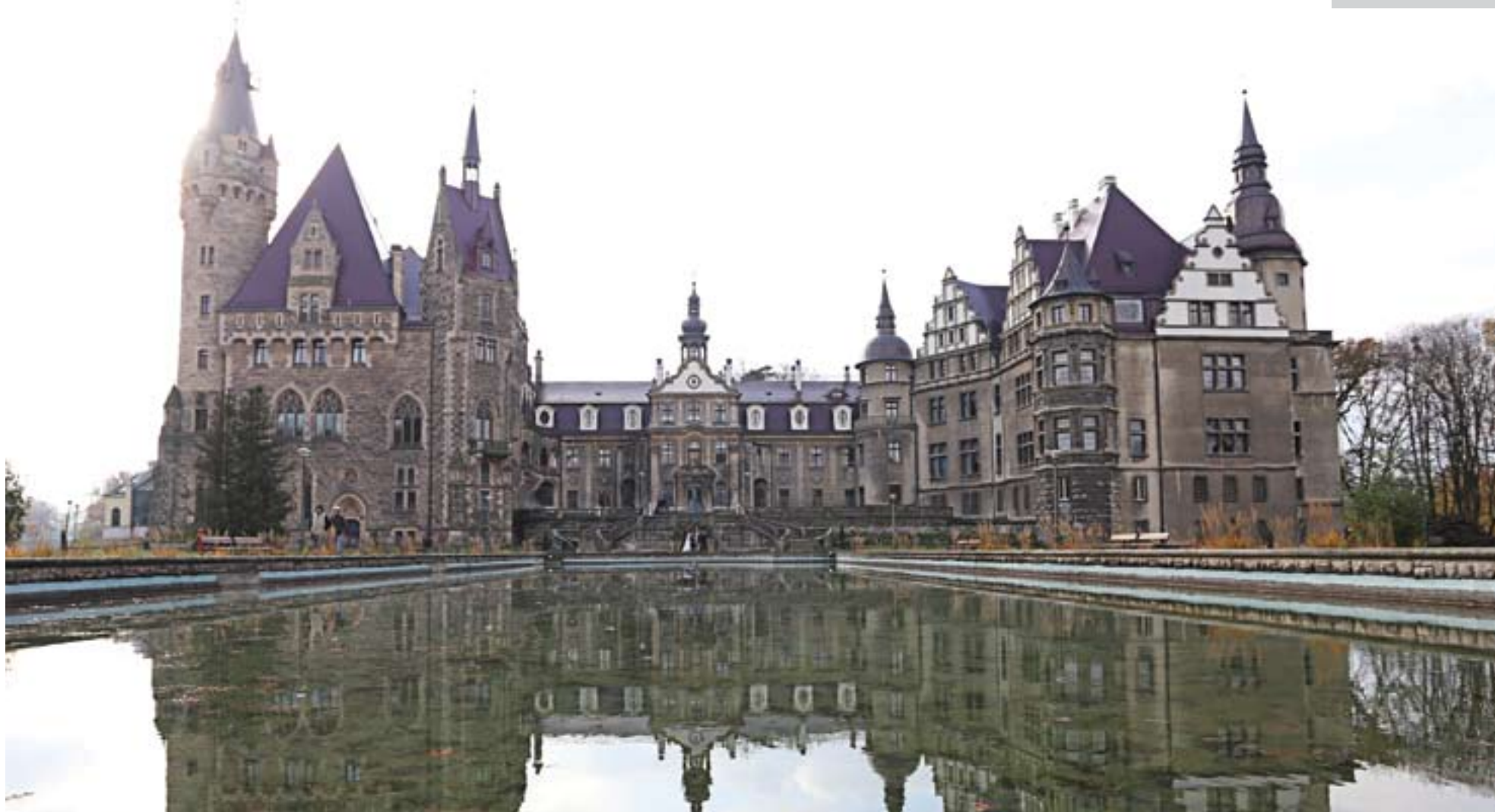
Fasada zamku w Mosznej zostanie w ramach projektu odnowiona.
